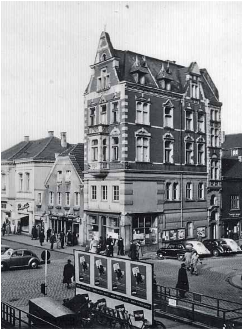
Der „lange Finger“ kurz vor dem Abriss
